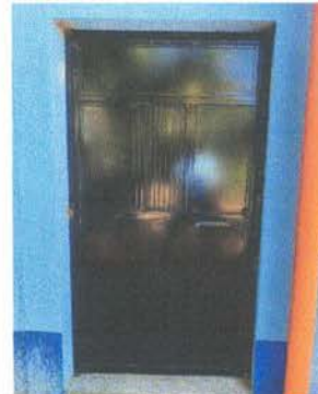
INSTALACIÓN DE PUERTAS DE METAL
