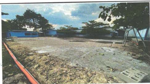
SUSTITUCION DE TUBERIA PVC LINEA PRINCIPAL
