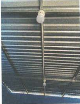
REPARACIÓN DE LAMPARAS LED
