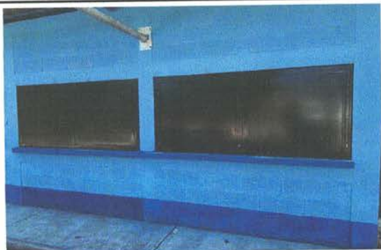
SUSTITUCIÓN DE VENTANAS DE METAL
