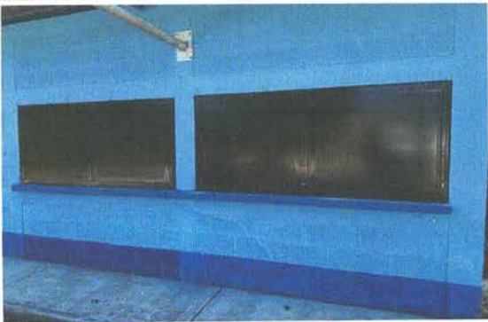
SUSTITUCIÓN DE VENTANAS DE METAL
