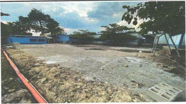
SUSTITUCION DE TUVERIA PVC LINEA PRINCIPAL
