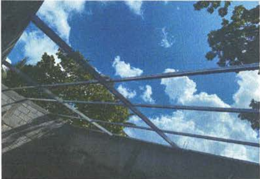
SUSTITUCIÓN DE ESTRUCTURA DE METAL
