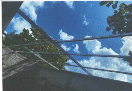
SUSTITUCIÓN DE ESTRUCTURA DE METAL
