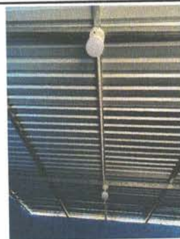
SUSTITUCIÓN DE LAMPARAS Y PLAFONERAS
