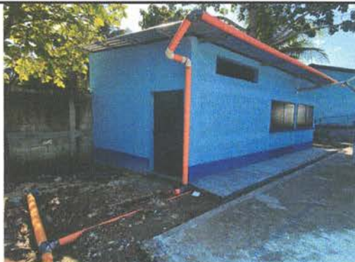
MANTENIMIENTO DE COCINA
