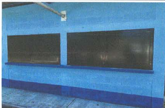
SUSTITUCIÓN DE VENTANAS DE METAL
