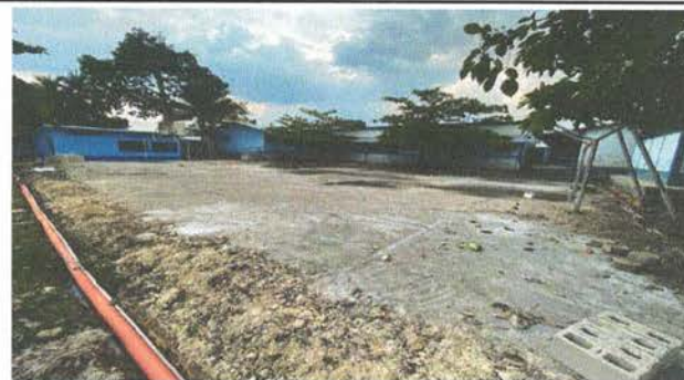
SUSTITUCION DE TUBERIA DE DRENAJE
