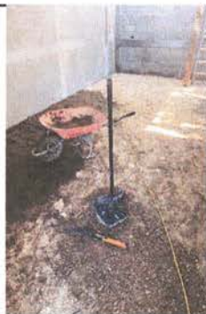
SUSTITUCIÓN DE PISO DE CONCRETO
