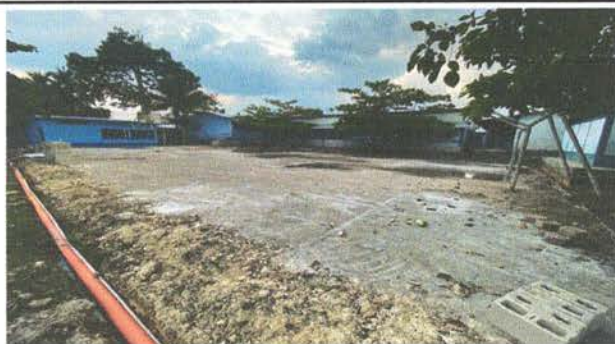
SUSTITUCION DE TUBERIA PVC LINEA PRINCIPAL
