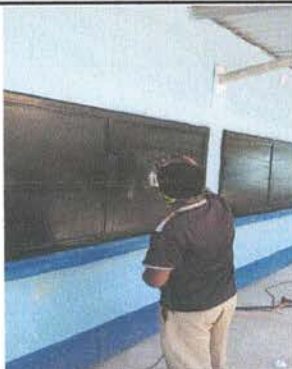
SUSTITUCIÓN DE VENTANAS DE METAL
