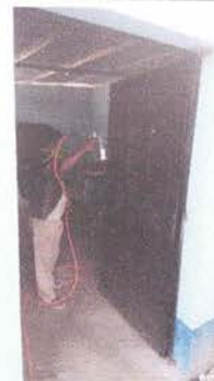
INSTALACIÓN DE PUERTAS DE METAL
