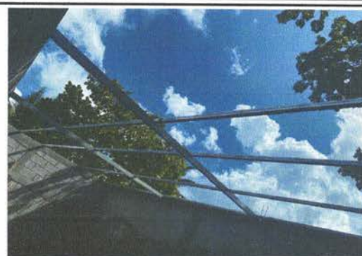
SUSTITUCIÓN DE ESTRUCTURA DE METAL
