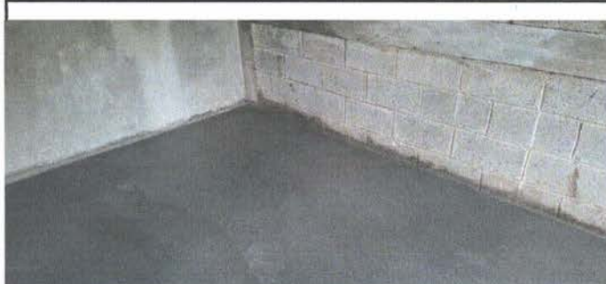
REPARACION DE PISO DE TORTA DE CONCRETO
