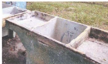
SUSTITUCIÓN DE PILA
