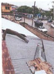
Foto 11: Desinstalación de lámina existente
