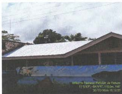
Foto 1: Sustrucción de lámina, por lámina troquelada aluzinc calibre 26
