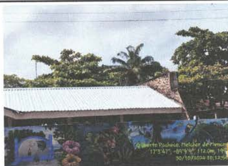
Foto 10: Instalación de lámina troquelada aluzinc cal. 26
