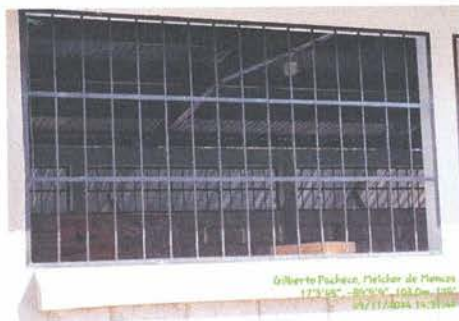
Foto 9: Fabricación e instalación de hierro en ventana
