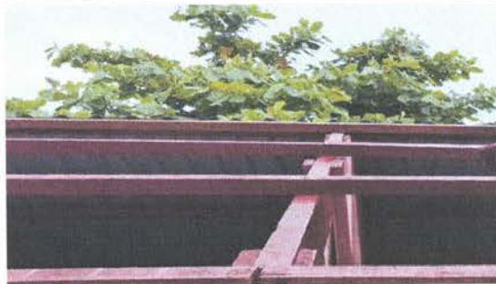
Foto 4: Mantenimiento de Soporte de madera (Reparación)
