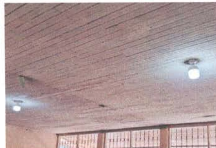
Foto 8: Reparación Sistema Eléctrico
