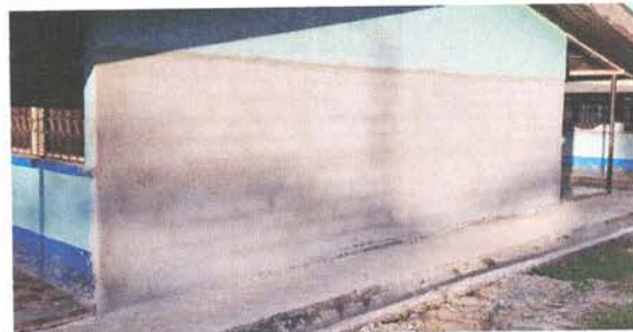
Foto 12: Repello en muros
