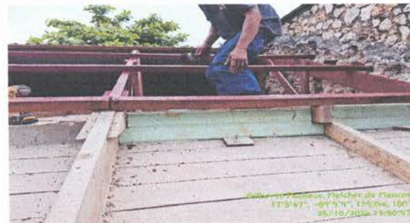
Foto 4: Mantenimiento de Soporte de madera (Reparación)
