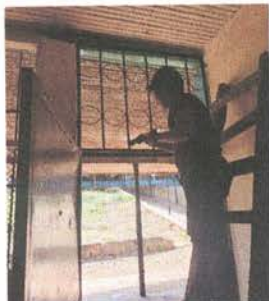
Foto 5: Mantenimiento de Puertas
