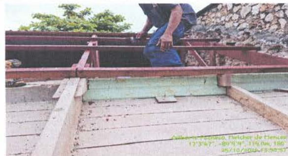
Foto 4: Mantenimiento de Soporte de madera (Reparación)
