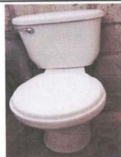
Foto 6: Servicios Sanitarios y sus accesorios
