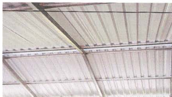
Foto 10: Instalación de lámina troquelada aluzinc
