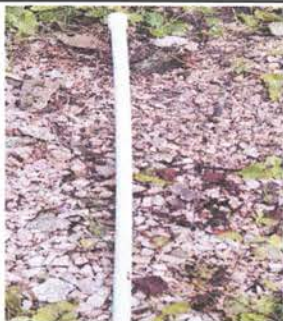
Foto 7: Sustrucción de tubería línea principal
