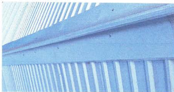
Foto 3: Sustrucción de elementos de fijación
