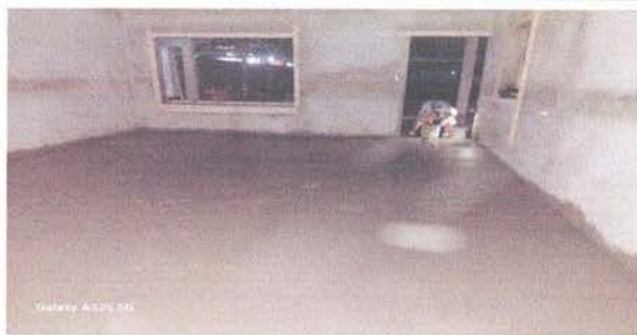
Foto 5: Sustrucción de piso de cemento líquido
