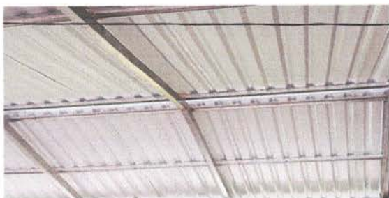
Foto 11: Desinstalación de lámina existente
