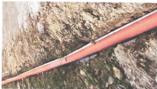
Foto 7: Sustrucción de tubería línea principal
