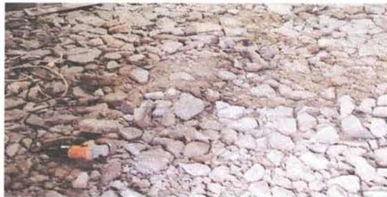
Foto 5: Sustrucción de piso de cemento líquido
