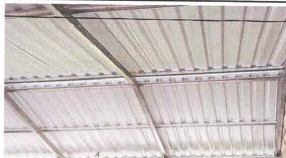
Foto 10: Instalación de lámina troquelada aluzinc
