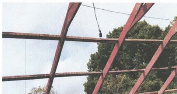
Foto 11: Desinstalación de lámina existente
