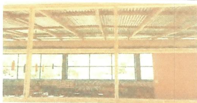
CAMBIO DE VENTANALES
