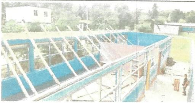
FOTO 3. SUSTITUCIÓN DE LAMINA TROQUELADA
