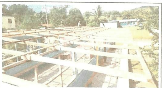
FOTO 3. SUSTITUCIÓN DE VIJAS DE MADERA POR ESTRUCTURA METALICA
