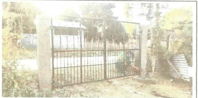
FOTO 5. SUSTITUCIÓN DE PORTONES
