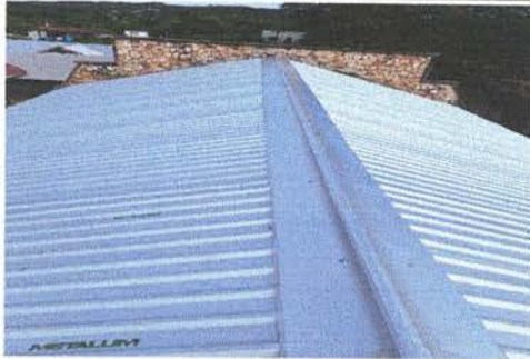
Foto 1: Sustitución de lámina, por lámina troquelada aluzinc calibre 26 (aula)
