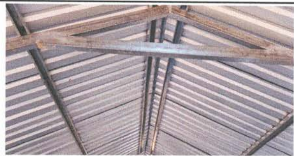
Foto 4: Sustitución de estructura de soporte de madera, por metal (Cocina)
