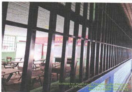
Foto 7: Fabricación e instalación de balcones de hierro en ventana (aula)
