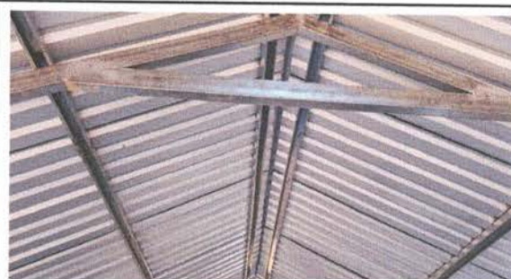
Foto 10: Desinstalación de lámina existente (cocina)
