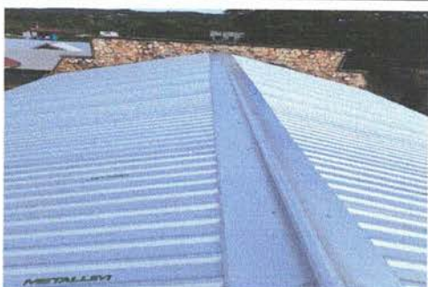
Foto 9: Desinstalación de lámina existente (aula)
