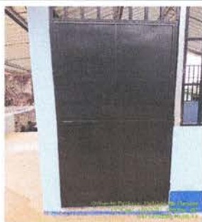
Foto 5: Sustitución de puerta de metal
