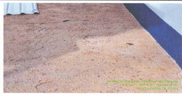
Foto 6: Sustitución de piso de cemento liquido
