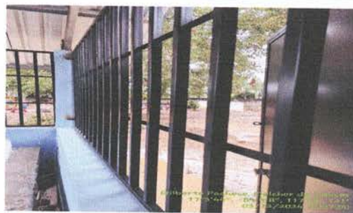
Foto 8: Fabricación e instalación de balcones de hierro en ventana (cocina)
