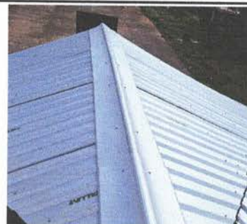
Foto 2: Mantenimiento a soporte de Madera (aula)
