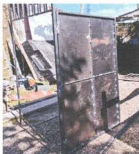
Foto 5: Sustitución de puerta de metal
