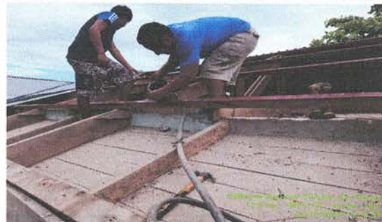
Foto 2: Mantenimiento a soporte de Madera (aula)
