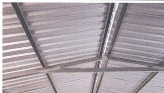
Foto 3: Sustitución de lámina, por lámina troquelada aluzinc calibre 26 (Cocina)
