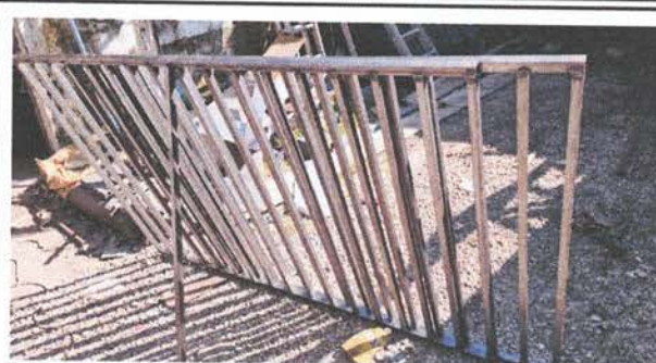
Foto 8: Fabricación e instalación de balcones de hierro en ventana (cocina)
