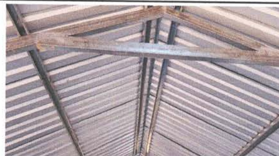
Foto 10: Desinstalación de lámina existente (cocina)
