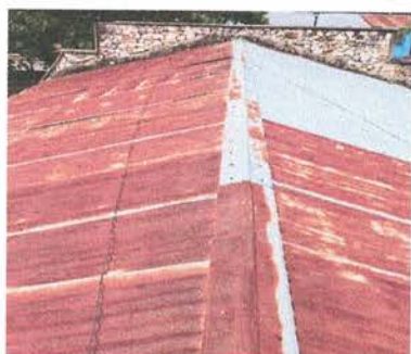
Foto 9: Desinstalación de lámina existente (aula)
