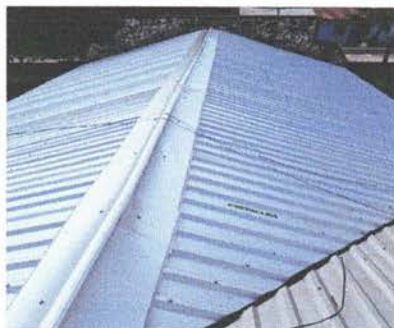
Foto 1: Sustitución de lámina, por lámina troquelada aluzinc calibre 26 (aula)
