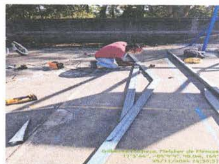
Foto 4: Sustitución de estructura de soporte de madera, por metal (Cocina)
