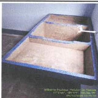
Foto 11: Sustitución de pila de cemento de dos lavadero
