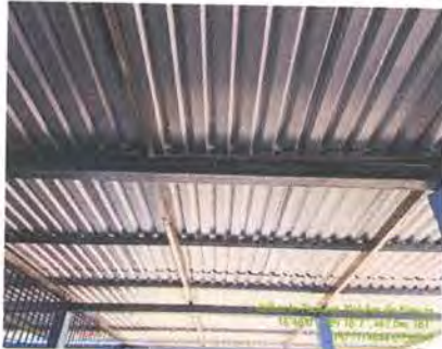
Foto 9: Instalación de lámina troquelada aluzinc
