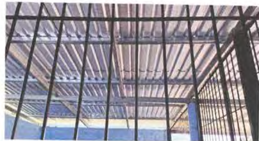
Foto 8: Instalación de estructura portante de metal
