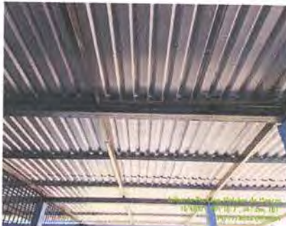
Foto 9: Instalación de lámina troquelada aluzinc
