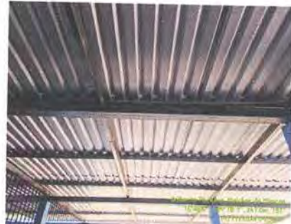
Foto 10: Desinstalación de estructura portante
