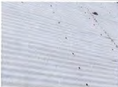
Foto 11: Desinstalación de lámina existente
