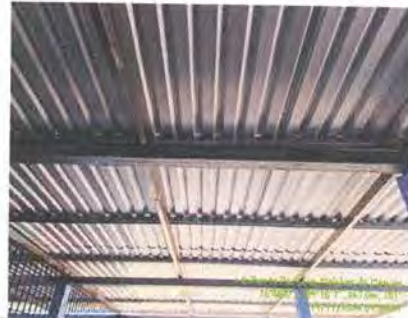
Foto 10: Desinstalación de estructura portante
