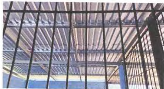
Foto 8: Instalación de estructura portante de metal
