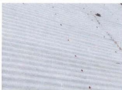
Foto 11: Desinstalación de lámina existente
