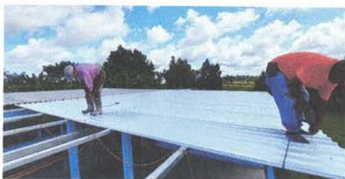
Foto 9: Instalación de lámina troquelada aluzinc
