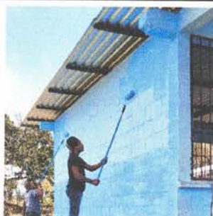
Foto 5: Pintura en muros exteriores e interiores
