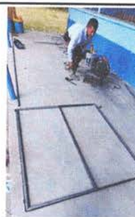
Foto 6: Fabricación e instalación de ventana-balcón de metal
