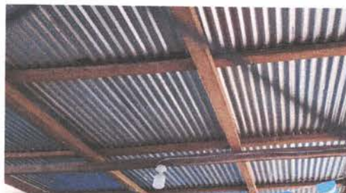
Foto 10: Desinstalación de estructura portante
