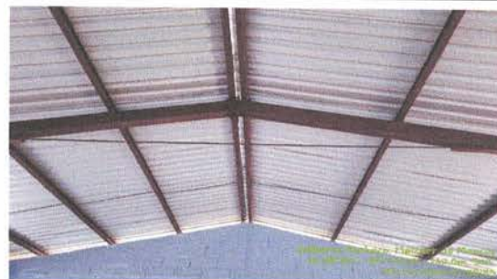
Foto 10: Desinstalación de lámina existente
