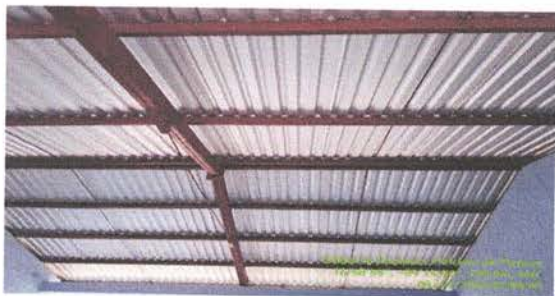
Foto 1: Sustrución de lámina, por lámina troquelada aluzinc calibre 26
