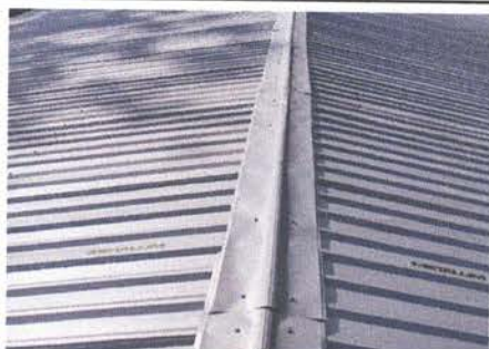
Foto 3: Sustrución de elementos de fijación
