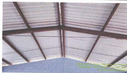
Foto 4: Mantenimiento a estructura de soporte de metal
