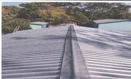
Foto 9: Instalación de lámina troquelada aluzinc
