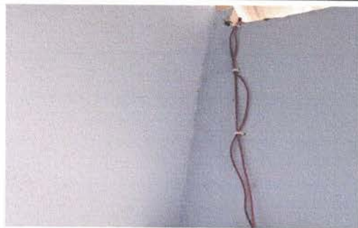
Foto 7: Sustrucción de ducto eléctrico + accesorios
