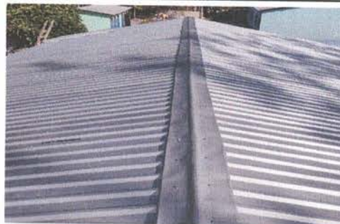
Foto 2: Sustrución de capote de lámina para lámina troquelada
