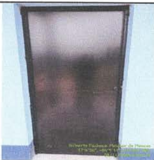
Foto 5: Mantenimiento a estructura (Puerta)
