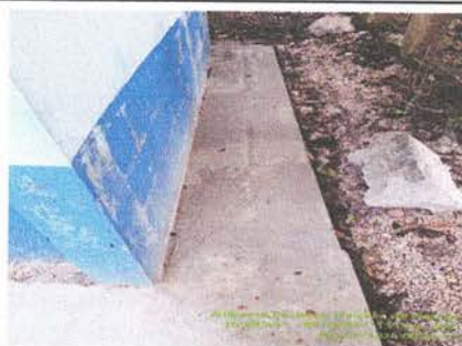
Foto 6: Reparación de plancha de concreto de patio
