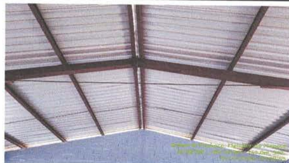
Foto 10: Desinstalación de lámina existente
