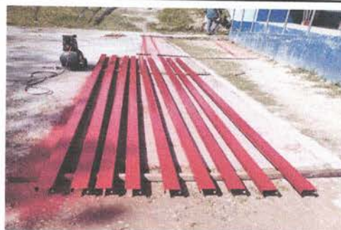
Foto 4: Mantenimiento a estructura de soporte de metal
