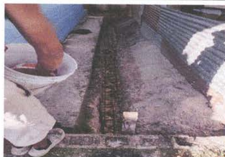
Foto 6: Reparación de plancha de concreto de patio
