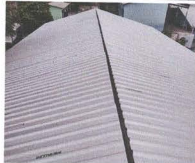
Foto 2: Sustitución de capote de lámina para lámina troquelada
