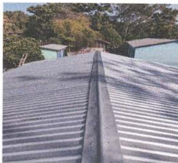
Foto 9: Instalación de lámina troquelada aluzinc
