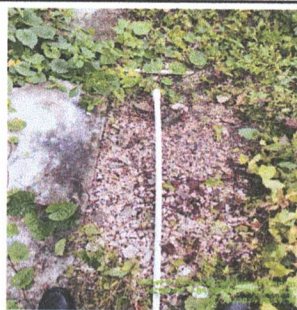
Foto 2: Sustitución de tubería línea principal
