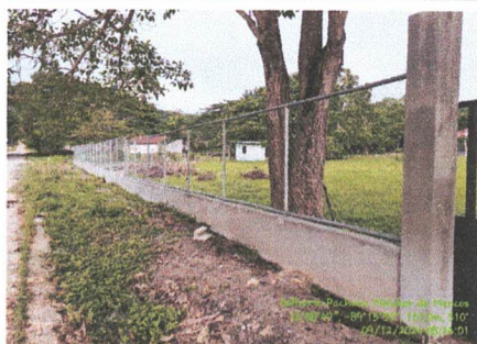
Foto 3: Reparación de tubo hg y malla galvanizada
