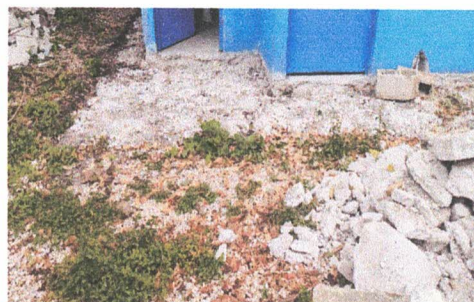
Foto 4: Reparación de planchas de concreto de patio
