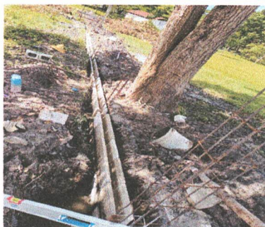
Foto 3: Reparación de tubo hg y malla galvanizada
