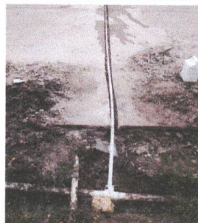
Foto 2: Sustitución de tubería línea principal
