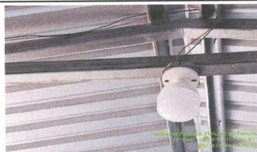
Foto 6: Reparación de cableado eléctrico
