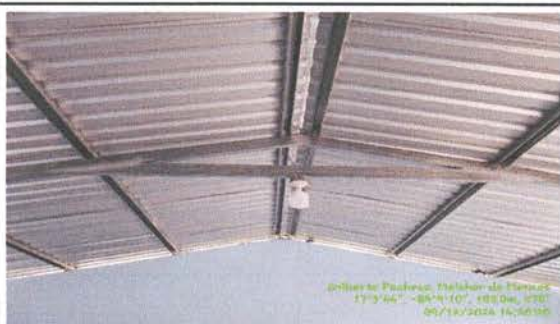
Foto 9: Instalación de estructura portante de metal
