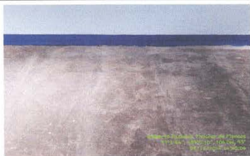
Foto 3: Sustitución de piso de cemento líquido
