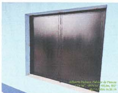
Foto 7: Fabricación e instalación de ventana-balcon de metal
