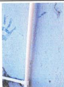
Foto 5: Sustitución de tubería línea principal
