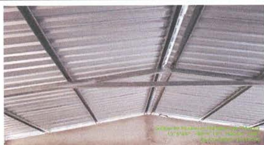
Foto 11: Desinstalación de estructura portante
