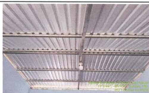
Foto 10: Instalación de lámina troquelada aluzinc
