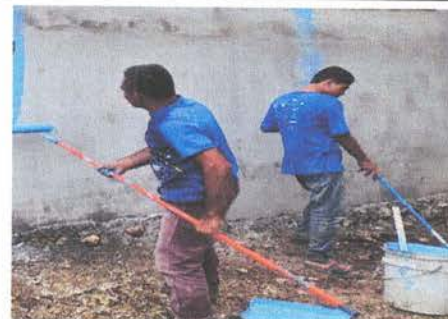
Foto 4: Pintura en muros exteriores e interiores
