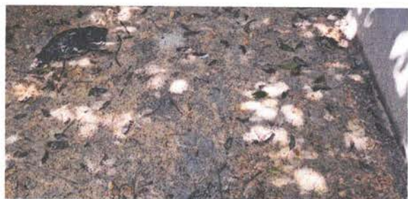
Foto 3: Sustrucción de piso de cemento liquido
