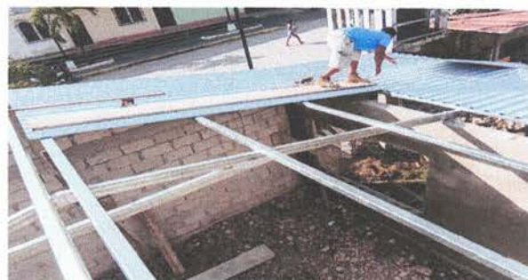
Foto 9: Instalación de estructura portante de metal
