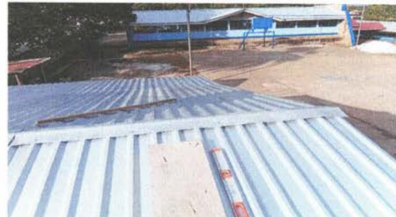
Foto 10: Instalación de lámina troquelada aluzinc
