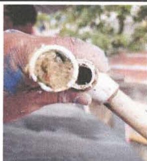
Foto 5: Sustrucción de tubería línea principal
