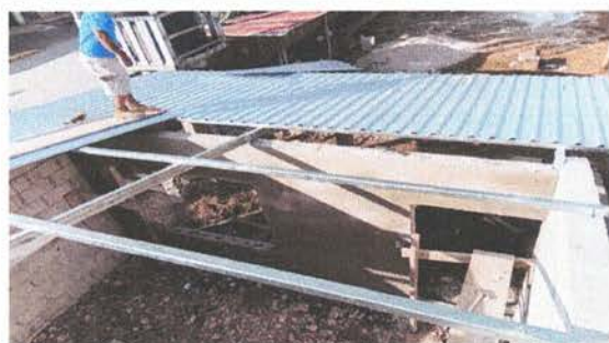
Foto 11: Desinstalación de estructura portante
