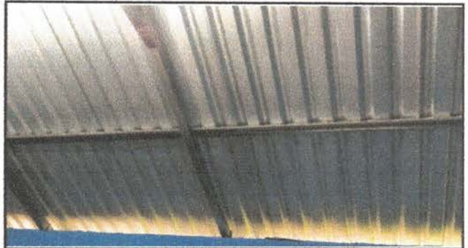
Instalación de estructura portante de metal
