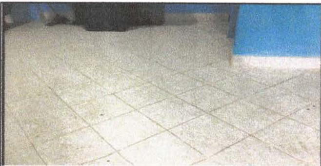
Sustitución de piso de torta de concreto
