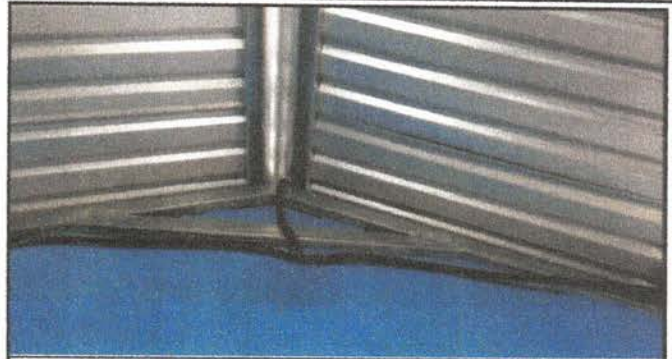
Reparación de sistema eléctrico
