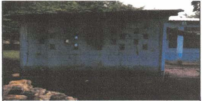
Desinstalación de lámina existente
