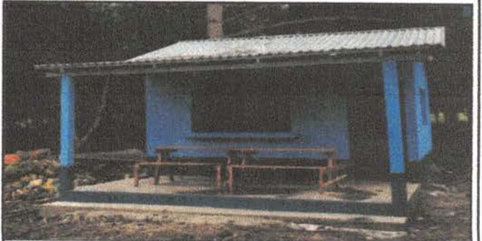
Pintura en muros exteriores e interiores
