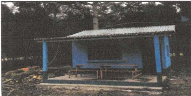
Instalación de lámina troquelada aluzinc
