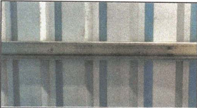
Sustitución de elementos de fijación
