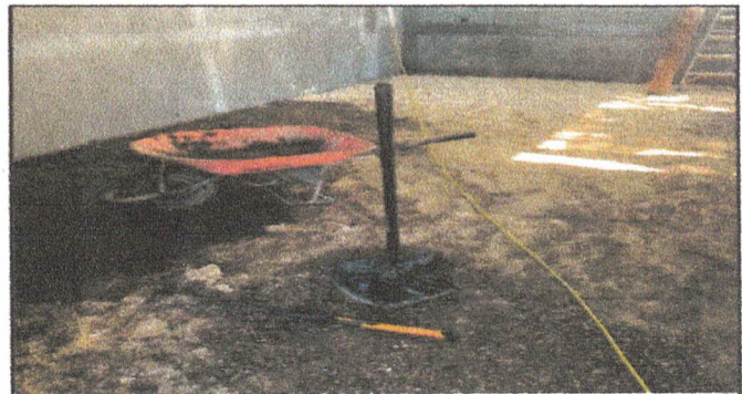
Sustitución de piso de torta de concreto
