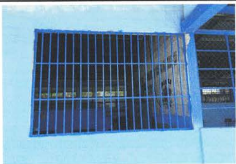
MANTENIMIENTO A ESTRUCTURA DE METAL DE VENTANA
