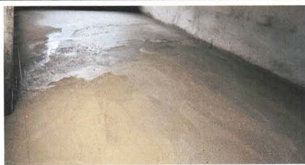
REPARACIÓN DE PISO DE TORTA DE CONCRETO
