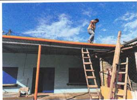
SUSTITUCIÓN DE TUBERÍA PVC LINEA PRINCIPAL DE AGUAS PLUVIALES
