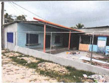
REPARACIÓN DE TUBO HG Y MALLA GALVANIZADA
