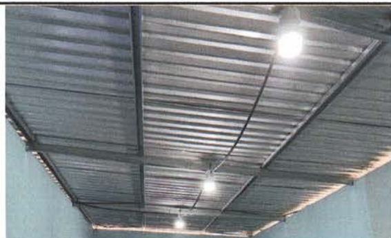
SUSTITUCIÓN DE LÁMINA, POR LÁMINA TROQUELADA ALUZINC CALIBRE 26
