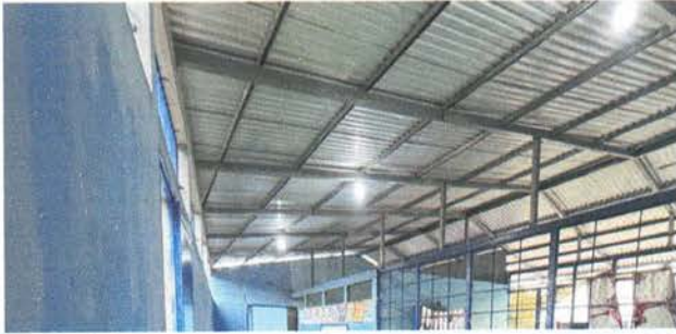
SUSTITUCIÓN DE DUCTO ELÉCTRICO + ACCESORIOS
