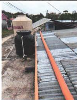
SUSTITUCIÓN DE TUBERÍA PVC LÍNEA PRINCIPAL DE AGUAS PLUVIALES
