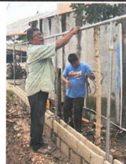
REPARACIÓN DE TUBO HG Y MALLA GALVANIZADA
