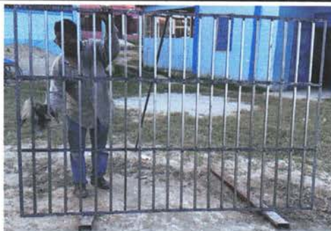
MANTENIMIENTO A ESTRUCTURA DE METAL DE VENTANA
