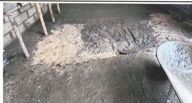
REPARACIÓN DE PISO DE TORTA DE CONCRETO
