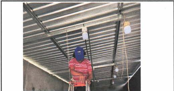
SUSTITUCIÓN DE DUCTO ELÉCTRICO + ACCESORIOS
