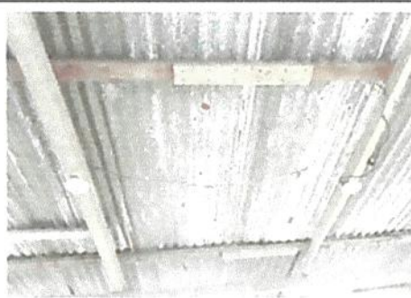
Reparacion de Sistema Electrico.
