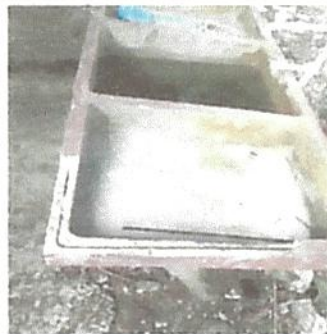
Reparacion de drenaje y red de agua potable.
