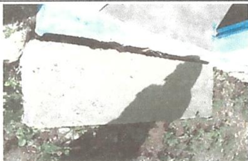
Sustitucion de Banqueta y cuneta.
