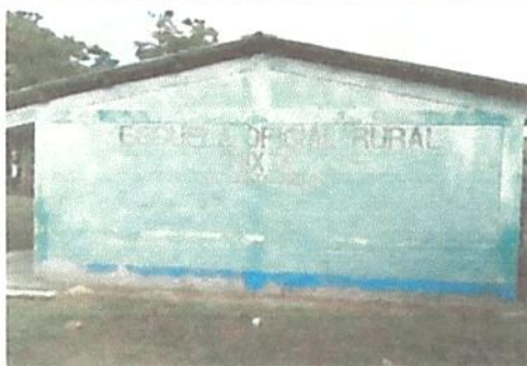
Pintura interior y exterior
