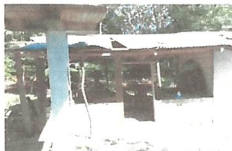
Sustitucion de lamina por lamina troquelada aluzinc calibre 26.
