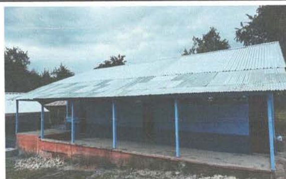
FOTO 10: Instalación de lámina troquelada Aluzinc.
