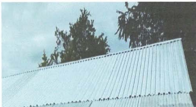
FOTO 3: Sustitución de capote de lámina troquelada
