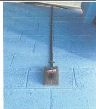
FOTO 8: Reparación de cableado eléctrico.
