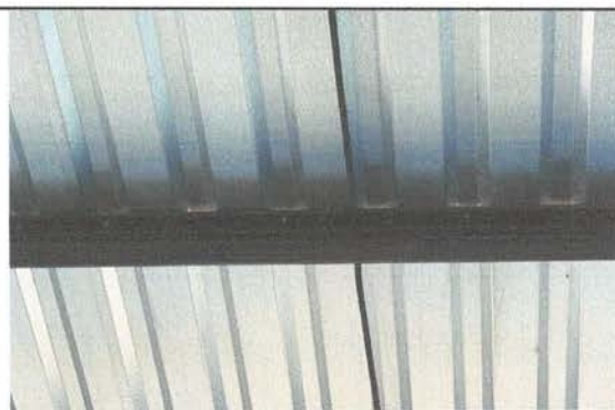
FOTO 4: Sustitución de elemento de fijación
