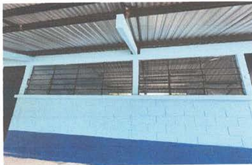
FOTO 5: Mantenimiento a estructura de metal por ventana
