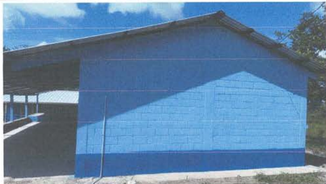
FOTO 7: Pintura en muros exteriores e interiores
