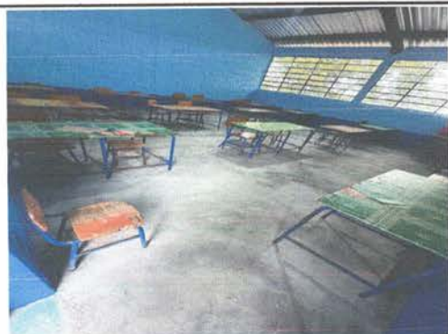
FOTO 9: Reparación de cemento líquido.
