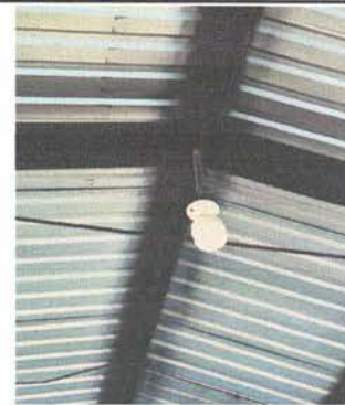
FOTO 8: Reparación de cableado eléctrico.
