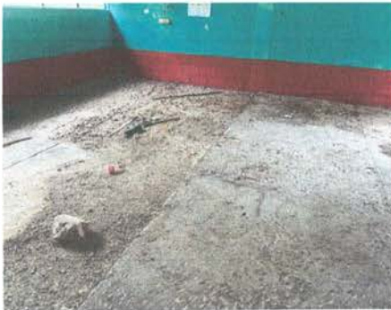
FOTO 9: Reparación de cemento líquido.
