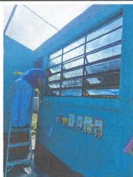
FOTO 5: Mantenimiento a estructura de metal por ventana
