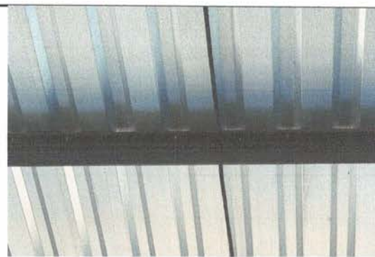
FOTO 4: Sustitución de elemento de fijación
