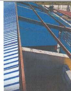
FOTO 10: Instalación de lámina troquelada Aluzinc.
