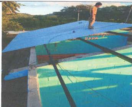
FOTO 1: Sustitución de lámina por lámina troquelada Aluzinc calibre 26
