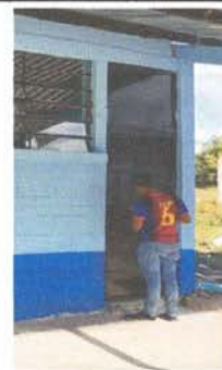
FOTO 6: Mantenimiento a estructura (lijado, cambio de tubo, cepillado, sujeciones, aplicación de pintura)
