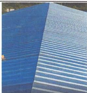
FOTO 3: Sustitución de capote de lámina troquelada
