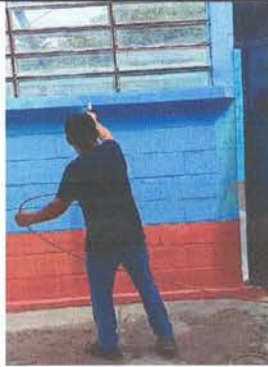
FOTO 7: Pintura en muros exteriores e interiores
