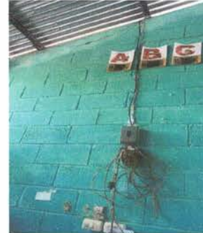
FOTO 8: Reparación de cableado eléctrico
