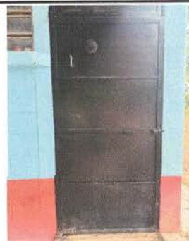
Foto 6: Mantenimiento a estructura (lijado, cambio de tubo, cepillado, sujeciones, aplicación de pintura)
