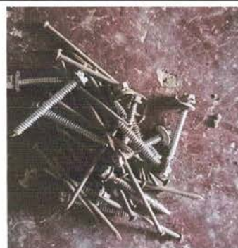
Foto 4: Sustitución de elementos de fijación
