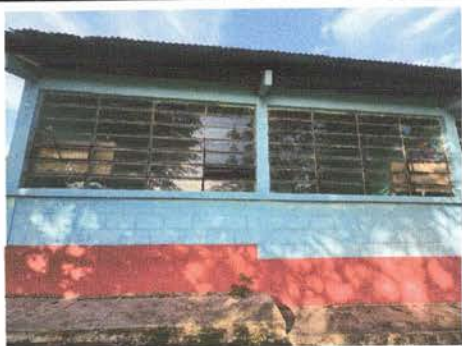
Foto 5: Mantenimiento a estructura de metal de ventana
