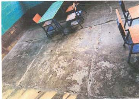
Foto 9: Reparación de piso de cemento líquido.
