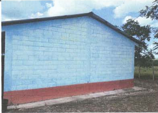
FOTO 7: Pintura en muros exteriores e interiores.
