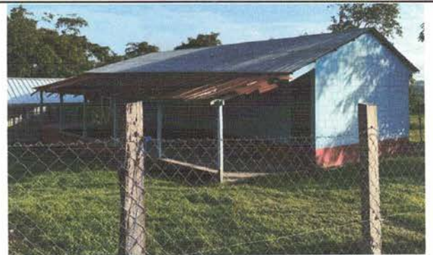
FOTO 10: Instalación de lámina troquelada Aluzinc
