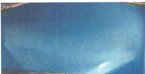
Foto 5: Pintura de muros exteriores e interiores
