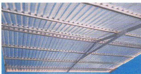
Foto 9: Instalación de estructura portante de metal
