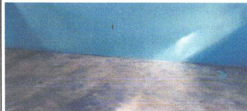
Foto 4: Reparación de piso de cemento líquido
