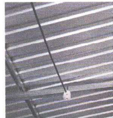
Foto 6: Reparación de cableado eléctrico
