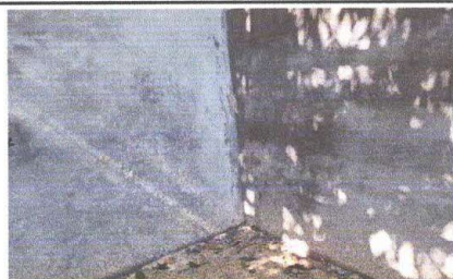
Foto 11: Repello en muro
