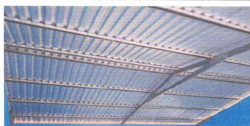
Foto 10: Instalación de lámina troquelada aluzinc
