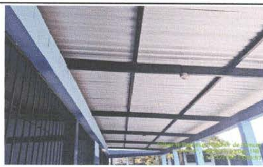
Foto 10: Instalación de lámina troquelada aluzinc
