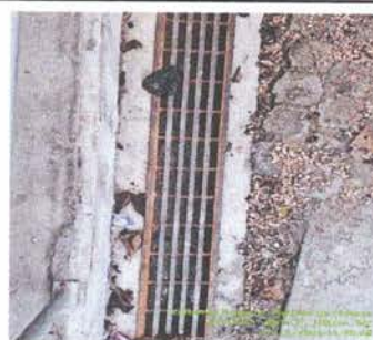
Foto 6: Reparación de cuneta de concreto
