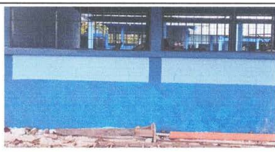
Foto 12: Repello en muro
