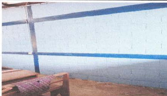
Foto 7: Pintura en muros exteriores e interiores
