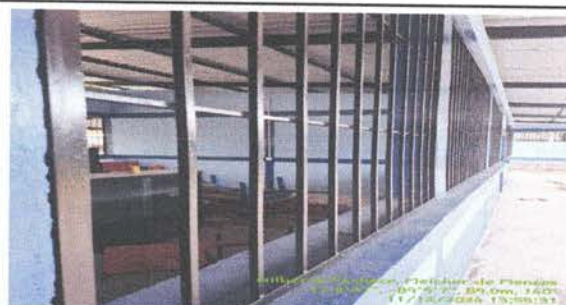
Foto 4: Mantenimiento a balcones de metal
