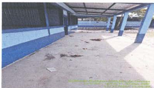
Foto 5: Sustrución de piso de cemento liquido
