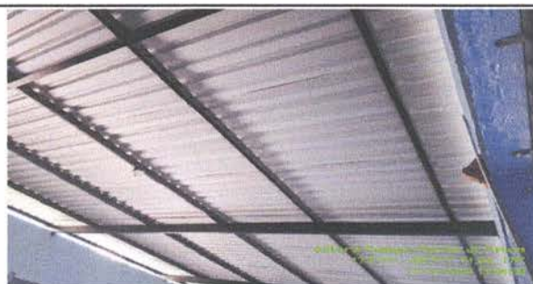
Foto 11: Desinstalación de lámina existente
