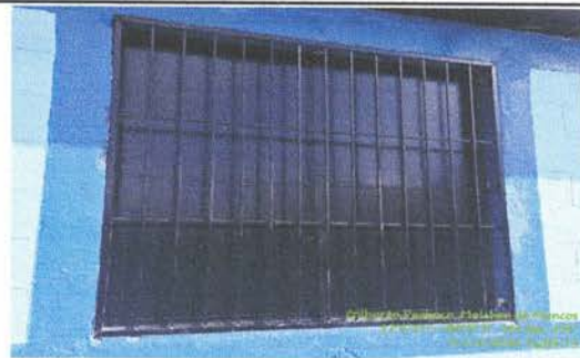
Foto 8: Fabricación e instalación de ventana-balcon de metal
