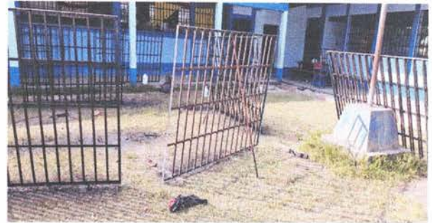
Foto 4: Mantenimiento a balcones de metal
