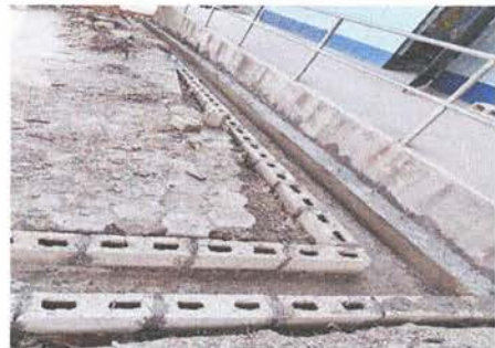
Foto 6: Reparación de cuneta de concreto
