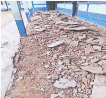
Foto 5: Sustrucción de piso de cemento liquido
