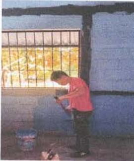
Foto 7: Pintura en muros exteriores e interiores
