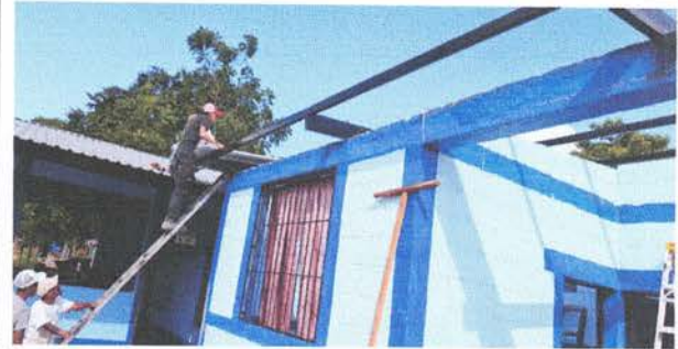
Foto 10: Instalación de lámina troquelada aluzinc
