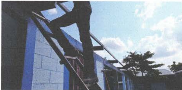
Foto 11: Desinstalación de lámina existente
