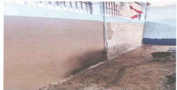
Foto 12: Repello en muro
