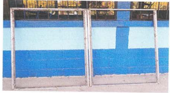
Foto 8: Fabricación e instalación de ventana-balcon de metal
