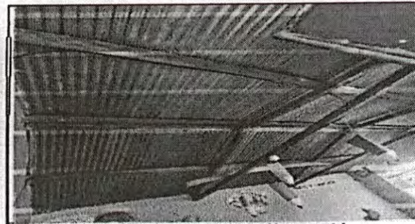
Foto 6. Estructura de madera que se va a cambiar por metal
