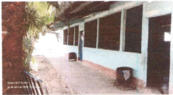
Foto 3: Mejoramiento de balcones. pinturas, energia electrica.
