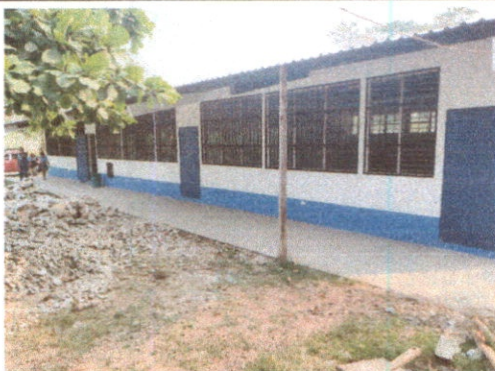
Foto 3: Pintura de muros exteriores e Interiores
