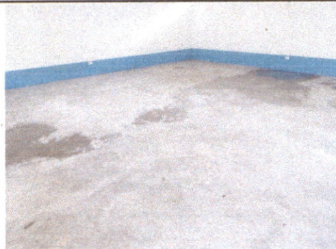
Foto 2: Susutitución de piso de cemento liquido
