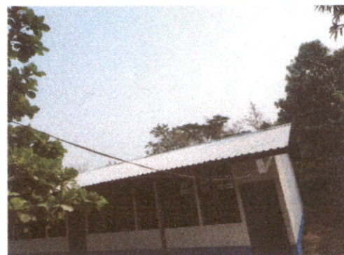
Foto 4: Cubierta de Lamina
