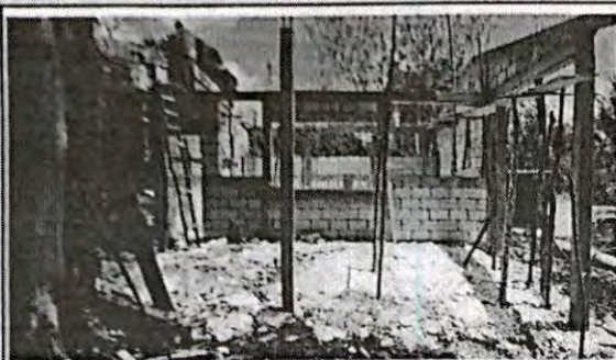
Foto 1: Vista frontal Columnas y paredes levantadas
