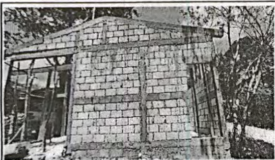
Foto 3 Vista lateral Derecha, se aprecia las columnas listas para la estructura del techo
