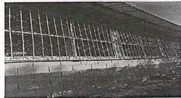
Foto 6: VISTA DE LA PARTE DE ATRÁS DEL MÓDULO 1, SE OBSERVA LA NECESIDAD DE PINTURA Y CAMBIO DE BALCONES
