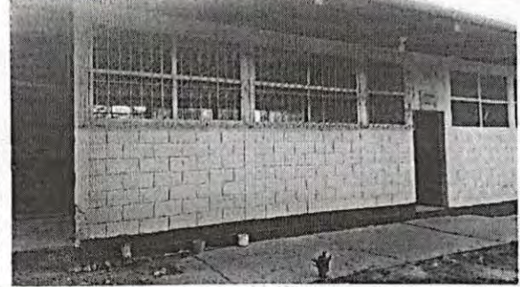
Foto 2: VISTA DE LA PARTE FRONTAL DEL SALÓN 1, SE APRECIA QUE NECESITA CAMBIO DE PUERTA, BALCONES, PINTURA Y BANQUETA.
