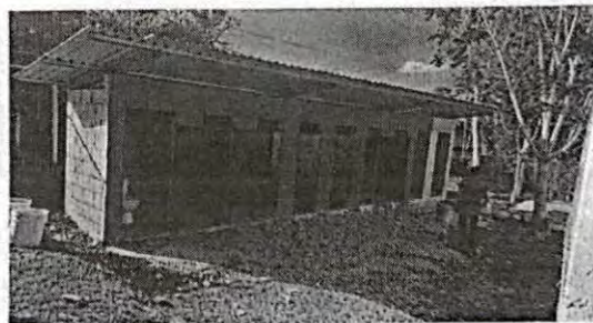
Foto 6: VISTA FRONTAL DEL MÓDULO II, DONDE SE REALIZARA COLOCACIÓN DE PISO CERÁMICO, AZULEJO, REPELLO Y PINTURA.
