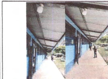
Foto 5 : Sustrución de focos ahorradores
