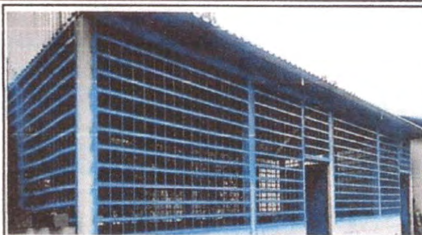
Foto 2 : Mantenimiento de balcones de metal
