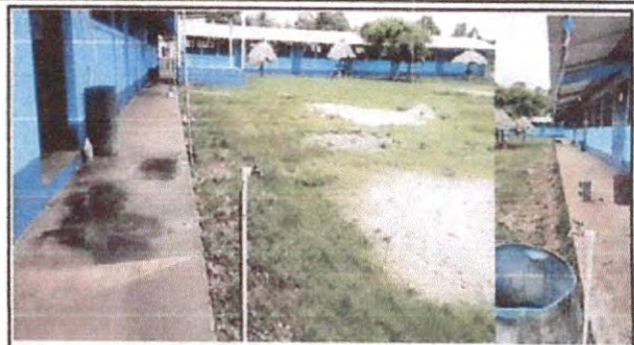
Foto 8 Instalacion de tuberia principal de pvc
