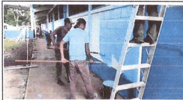
Foto 3 : Pintura en muro exteriores e interiores
