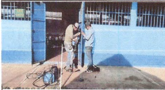
Foto 1 : Sustitucion de chapas
