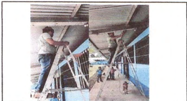
Foto 4 : Sustitucion de lámpara Led a foco ahorradores
