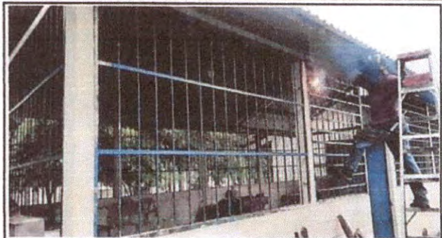
Foto 2 : Mantenimiento de balcones de metal
