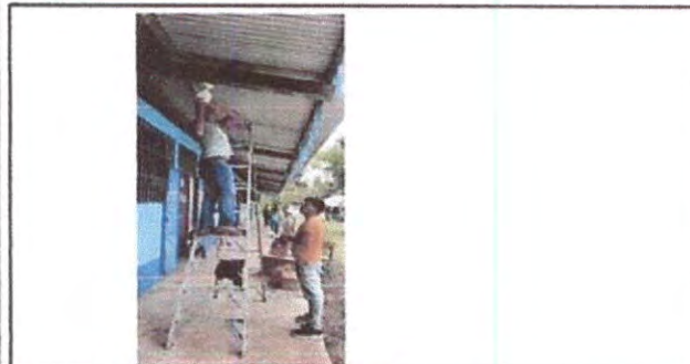
Foto 5 : Sustitucion de focos ahorradores
