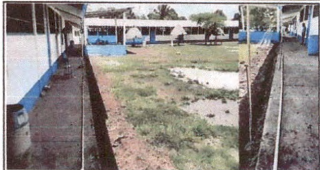
Foto 8 Instalacion de tubería principal de pvc
