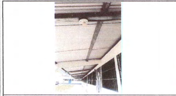
Foto 5 : Sustitucion de focos ahorradores
