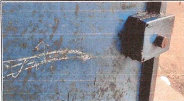
Foto 1 : Sustitucion de chapas
