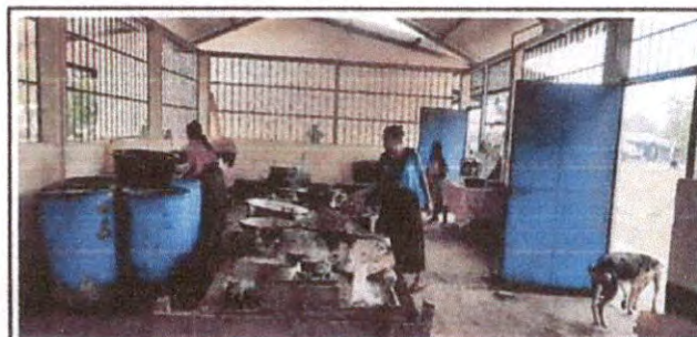
Foto 10 Mantenimiento a estructura
