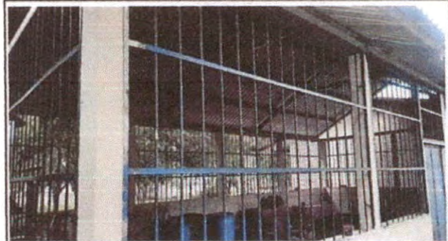
Foto 2 : Mantenimiento de balcones de metal
