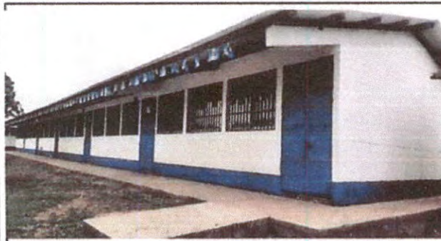
Foto 3 : Pintura en muro exteriores e interiores
