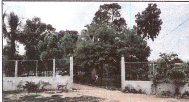
Foto 7 Fabricación e instalación de portón de metal de ingreso
