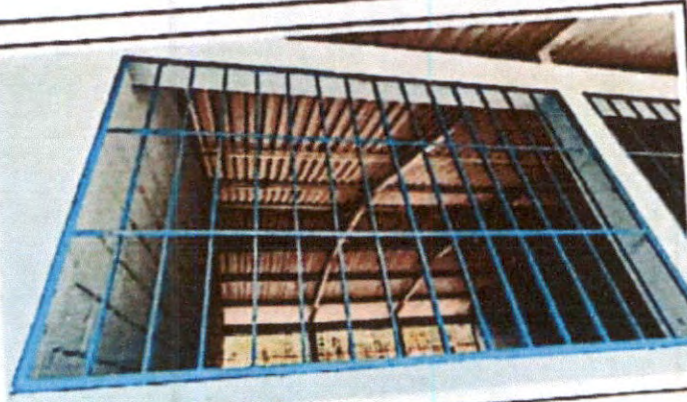
Foto 9: Instalación de Balcones
