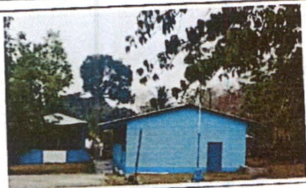
Foto 3: Repello en muro exterior en módulo
