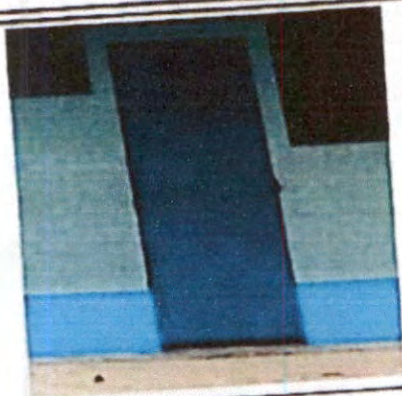
Foto 7: Mantenimiento a estructura de puertas de metal.
