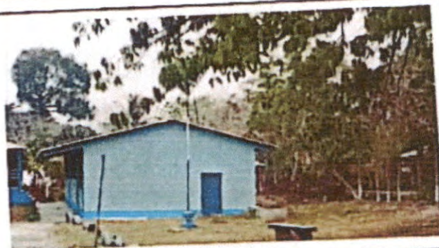
Foto 4: Pintura en muros de exterior e interior
