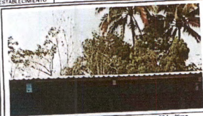
Foto 1: Instalación de lámina troquelada aluzinc calibre 26 legítimo
