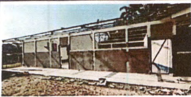
Foto 3: Repello en muro exterior en módulo
