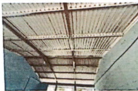
Foto 10: Instalación de unidades de luz
