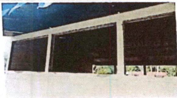
Foto 9: Instalación de balcones
