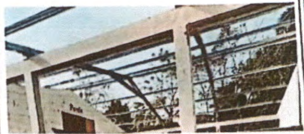
Foto 2: Instalación de estructura de soporte de metal.
