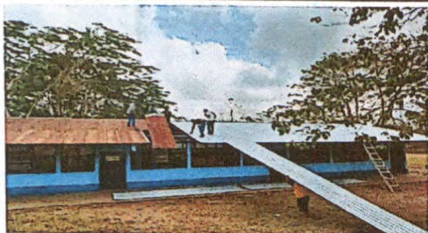
Foto 1: Se observa la colocación de láminas nuevas
