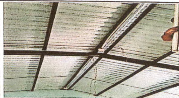
Foto 6: desmonte de lamparas en mal estado e instalación de nuevas.
