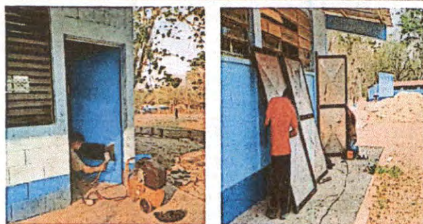
Foto 3: Mantenimiento y colocación de puertas nuevas
