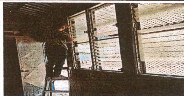
Foto 4: Sustitución de persianas en mal estado
