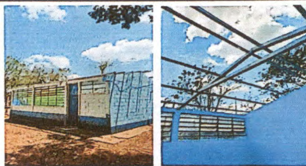
Foto 2: Colocación de lámina y nueva estructura
