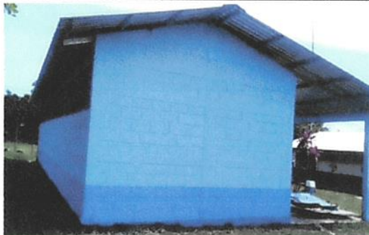
Foto 4: Pintura en muros exteriores e interiores
