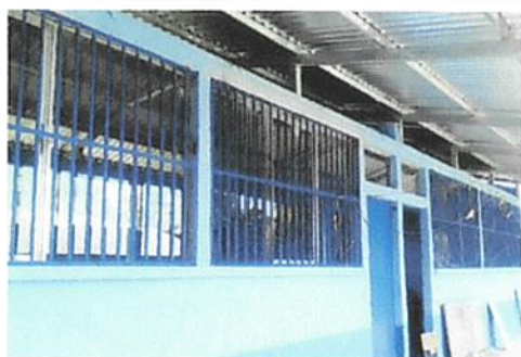
Foto 3: Fabricación e instalación balcon de metal
