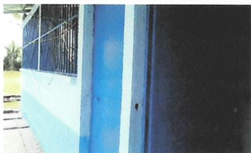
Foto 5: Sustrucción de Puerta
