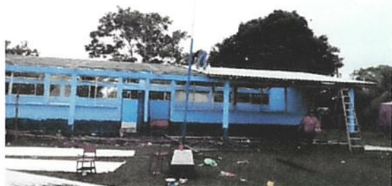
Foto 1: Recepcion de lámina, por lámina troquelada aluzinc calibre 28
