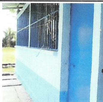
Foto 6: Sustitución de Puerta
