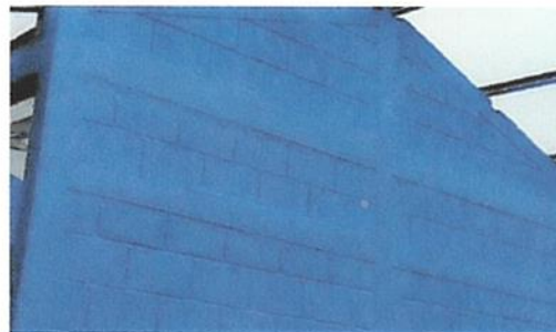
Foto 4: Pintura en muros exteriores e interiores
