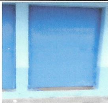
Foto 5: Sustitución de Puerta
