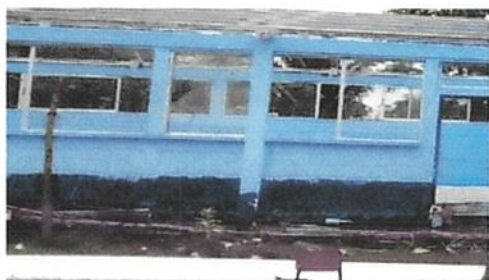
Foto 3: Fabricación e instalación balcon de metal
