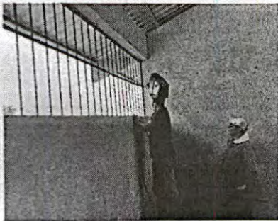
Foto 3: Vista interior donde se colocaran ventanas de vidrio
