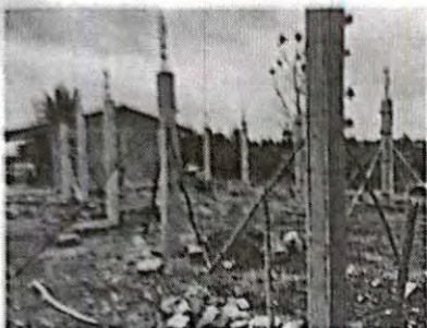
Foto 1: vista frontal columnas sobre las que irá la cubierta de lámina
