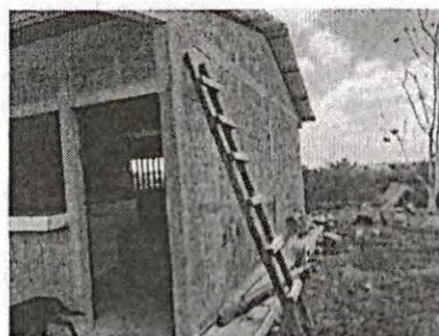
Foto 4: vista lateral donde se colocará la estructura del techo
