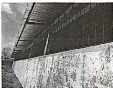
Foto 3: vista trasera donde se colocará ventanas de vidrio
