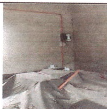
Foto 6: intalando tablero de 6 polos en el aula 1
