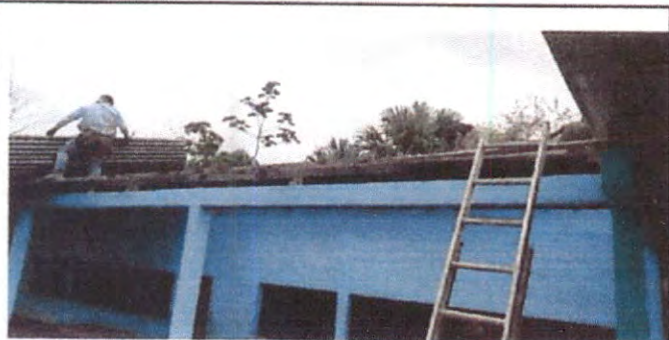
Foto 3: desmontando el techo del aula 3
