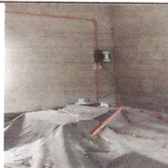
Foto 6: intalando tablero de 6 polos en el aula 1
