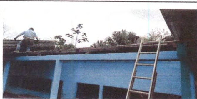
Foto 3: desmontando el techo del aula 3
