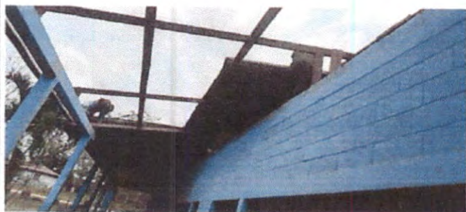
Foto 1: Desmontando el techo dl aula 1
