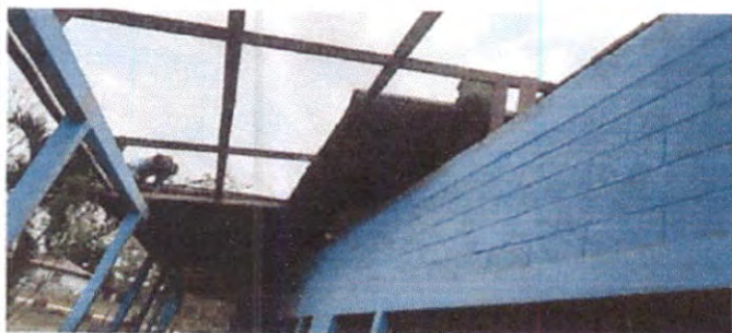
Foto 1: Desmontando el techo de aula 1
