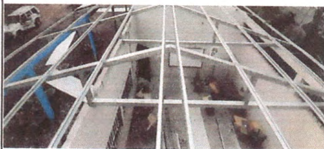
Foto 4: Instalando soportes para la lamina troquelada Aula 4
