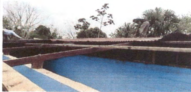
Foto 2: Desmontando el techo del aula 2
