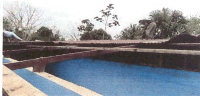
Foto 2: Desmontando el techo del aula 2
