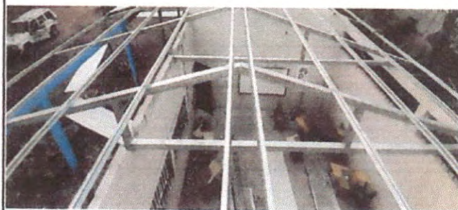
Foto 4: Instalando soportes para la lamina troquelada Aula 4
