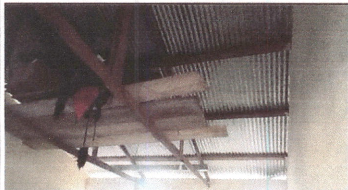
Foto 3: Techo tercera aula
