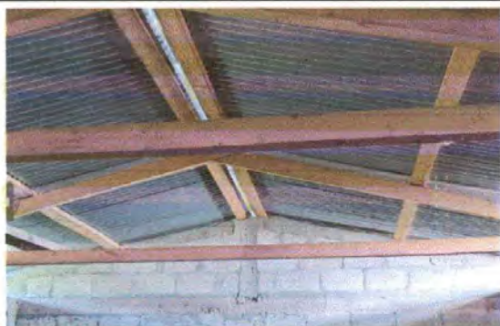
Foto 5: VISTA INTERIOR DE MODULO 1, S VISUALIZA LA FLEXIÓN DE LOS ELEMENTOS PORTANTES DE LA CUBIERTA
