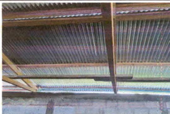
Foto 4: VISTA DE CUBIERTA, SE APRECIA EL MAL ESTADO DE LA ESTRUCTURA PORTANTE
