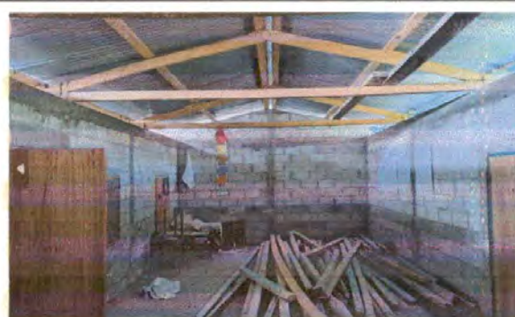
Foto 12: VISTA INTERIOR DE MODULO 1, SE OBSERVA EL MAL ESTADO DE LOS MUROS ASÍ COMO EL MAL ESTADO ACTUAL DE LA ESTRUCTURA PORTANTE DE LA CUBIERTA
