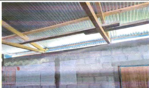
Foto 11: VISTA INTERIOR DE MODULO 1, SE OBSERVA LOS REFUERZOS QUE SE LE HAN INSTALADO A LA ESTRUCTURA PORTANTE
