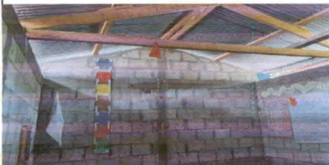
Foto 3: VISTA INTERIOR DE MODULO 1, SE APRECIA LA FALTA DE REPELLO EN EL INTERIOR DE LOS MUROS
