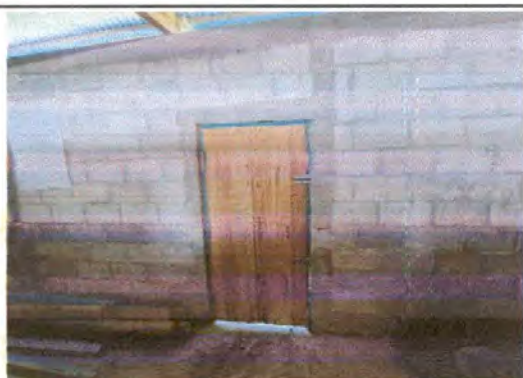
Foto 9: VISTA INTERIOR DE MODULO 1, SE APRECIA LA FALTA DE REPELLO EN LOS MUROS
