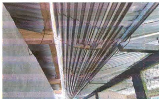
Foto 2: VISTA DE LA FALTA DE CANAL DE AGUA, POR LO QUE SE MOJA EL AULA QUE SE ENCUENTRA AL COSTADO DEL MODULO 1
