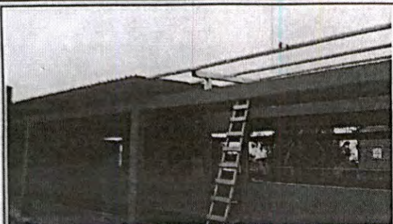
Foto1: vista del modulo, se cambio el techo por deterioro del techo anterior.
