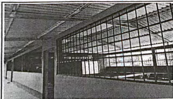
Foto 3: vista del modulo, se cambiaron los balcones de antes por deterioro y se colocaron balcones de metal.
