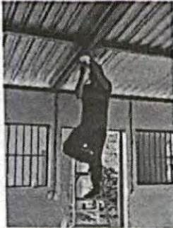
Foto: 7 Vista del mejoramiento de energía eléctrica
