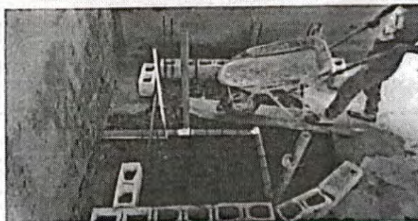
Foto: 4 Vista de las bases de pila para depósito y labaderos del módulo 2 cocina
