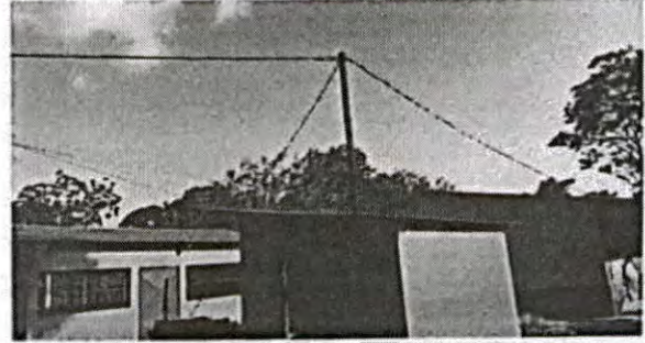
Foto: 8 Vista del mejoramiento y levantado de acometida de energía, que se constituya en peligro para la comunidad educativa
