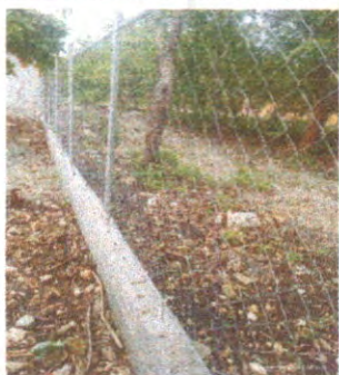
Foto1: Sustrucción de malla en muro perimetra
