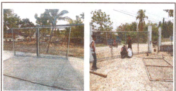
Foto 6: Mantenimiento a portones de metal
