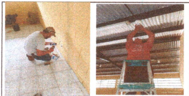
Foto 5: Sustitución de focos ahorradores, tomacorrientes dobles y plafonera
